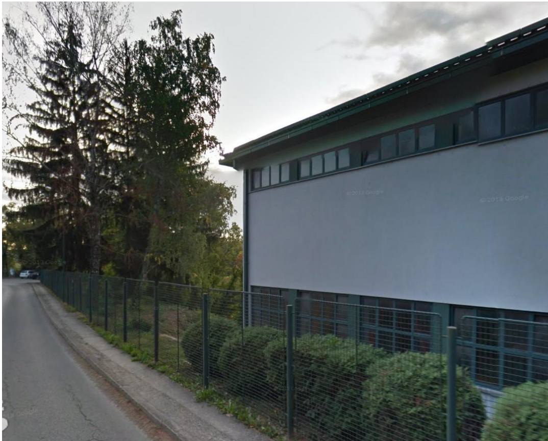
Slika 10.7 Lokacija nove TS uz postojeću zgradu 35 kV rasklopnice HE Ozalj 2
