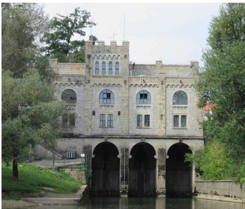
Slika 3.14 Zgrada HE Ozalj
