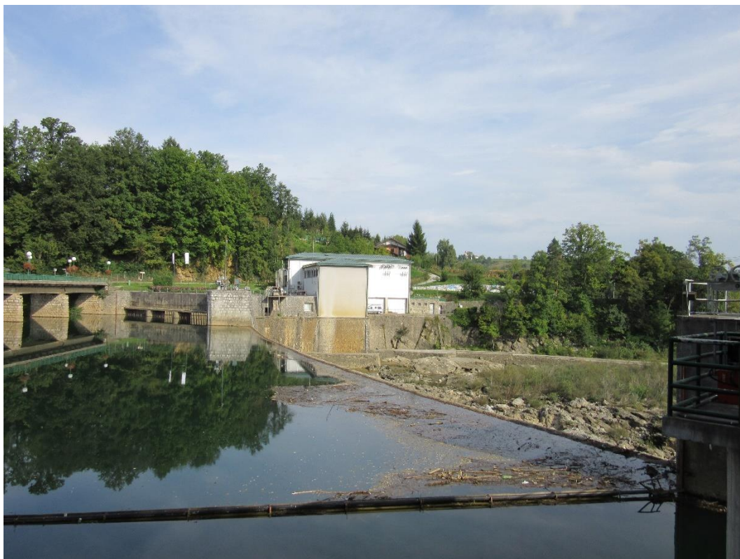
Slika 10.3 Pogled preko branu na zgradu HE Ozalj 2
