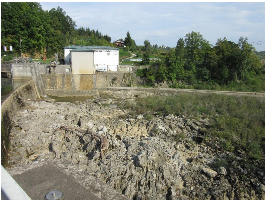
Slika 10.4 Brana je izgrađena na prirodnoj stepenici na području Korita rijeke Kupe
